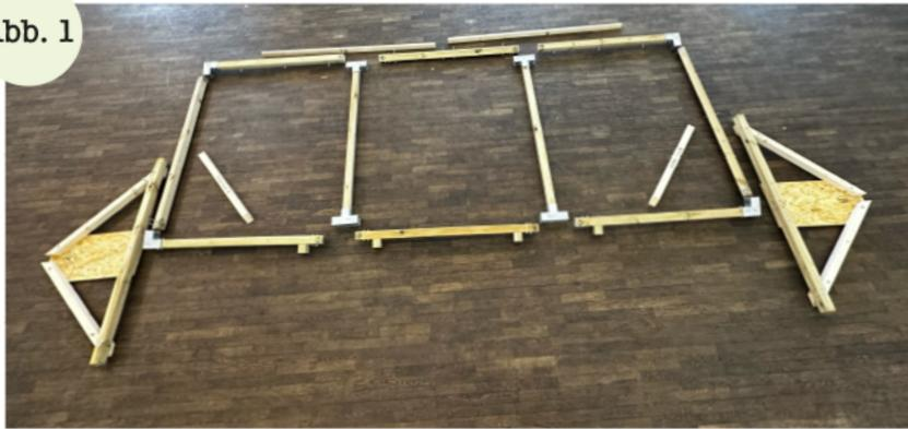
3. Verschraubt den Rahmen mit den Seitenteilen A&B wie in Abb.3. In den Balkenverbindern (T-Form) sind kleine Bohrlöcher mit ca.4mm Durchmesser, in diese müsst Ihr noch die Rundhaken einschrauben. Die 45° Stützen werden mit je zwei Spaxschrauben wie in der Abb.3 eingeschraubt. Dafür benötigt Ihr den Akkuschrauber mit dem 20 Torx Bit.
