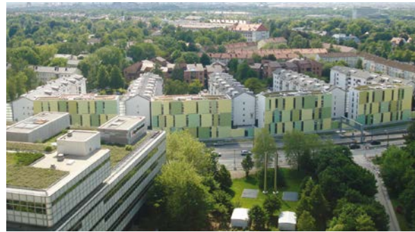
Abbildung 47: Verbesserung des Schallschutzes durch zusätzliche Abschirmung oder Bebauung mit geeigneter Raumorientierung im Gebäude (Foto Kühne)
