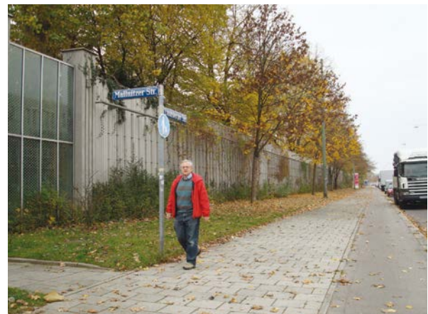
Abbildung 31: Lärmschutzwand entlang einer innerstädtischen Hauptverkehrsstraße (Foto Kühne)
