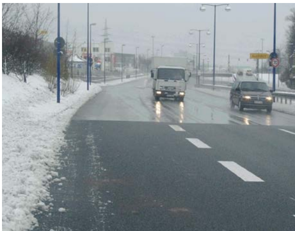
Abbildung 21: Übergang von einer geschlossenen Fahrbahndecke zu einer offenporigen Deckschicht bei Nässe (Foto Kühne)
