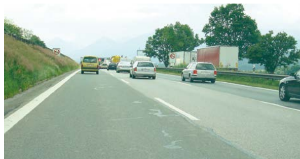
Abbildung 24: Unterschiedliche Deckschichten auf einer Autobahn mit nicht definiertem Geräuschverhalten (Foto Kühne)
