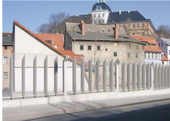
Abbildung 38: Glaswand mit absorbierenden Eigenschaften (Foto R. Kohlhauer GmbH)
