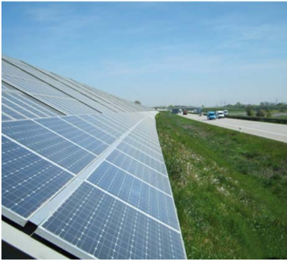
Abbildung 45: Lärmschutzwall mit aufgesetzter Photovoltaikanlage (Foto Kühne)
