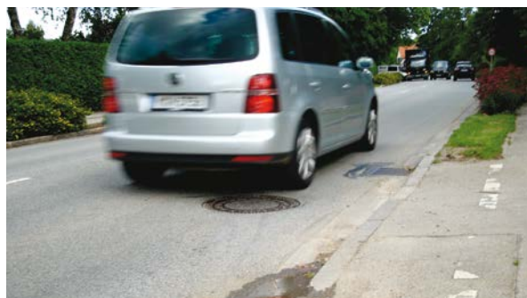
Abbildung 26: Kanaldeckel in der Rollspur als zusätzliche Schallquelle (Foto Kühne)
